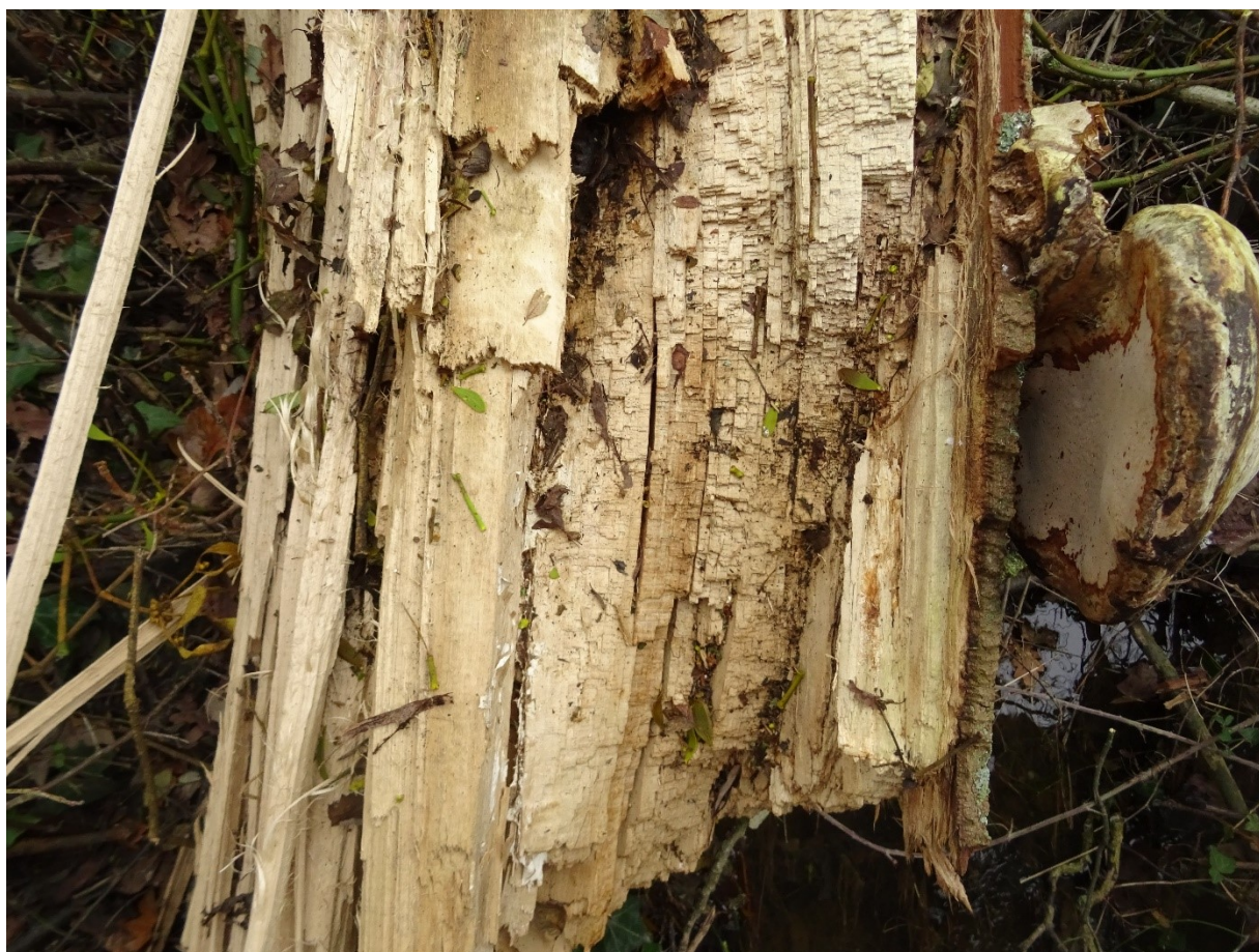
Photo 4 : coupe longitudinale naturelle de la base de l'axe qui a rompu. A gauche (face SO), du bois sain. A droite (face NE), le bois altéré.
